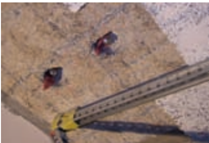
Bild 9: versenkte Verankerung
