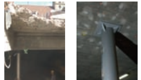
Bild 3: Deckenverstärkung
